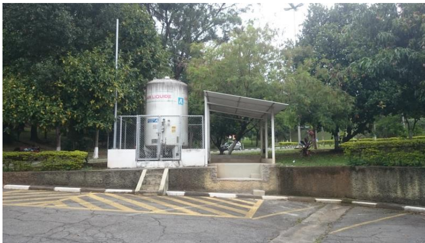
Figura 1: Pátio estacionamento e infraestrutura para carga e descarga
