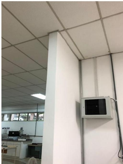
**Foto 3: Rack 12U de parede, existente**
